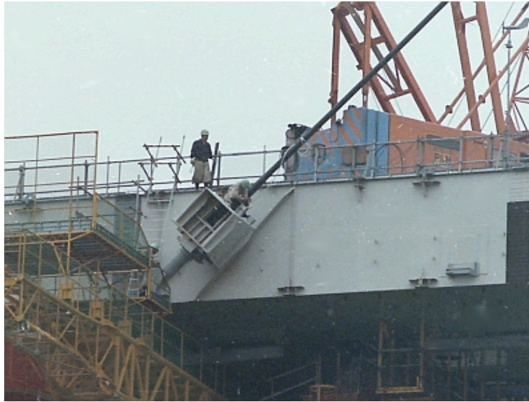
写真 3.6 安治川（多分，天保山）橋梁 斜張橋の桁側ケーブル定着部 1991 年竣工
