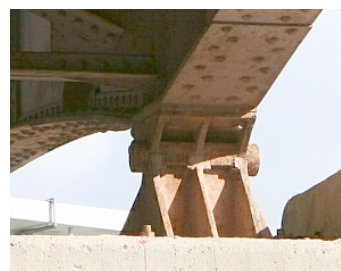
写真 2.4 橋脚天端に載っている支承
